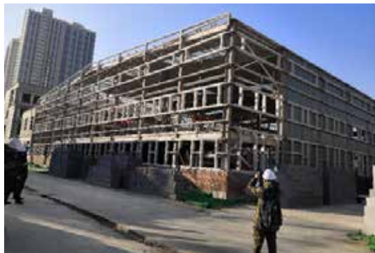
建设中的实验室
